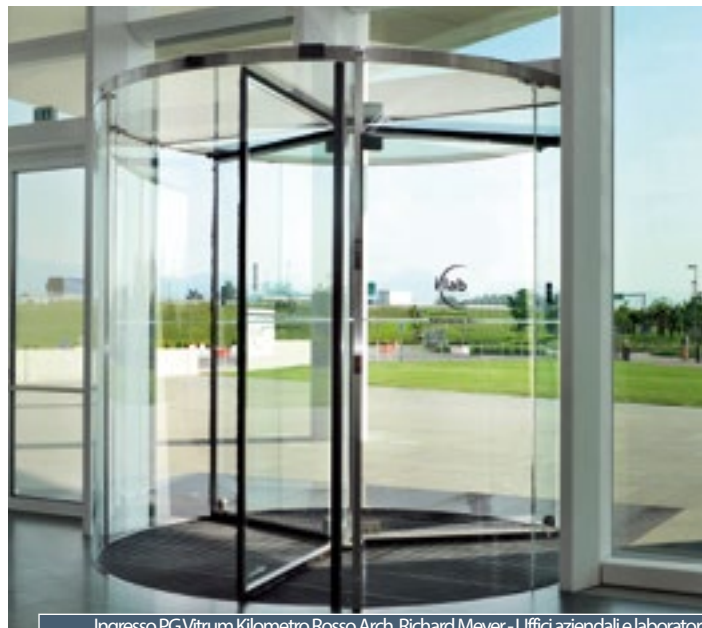
Ingresso PG Vitrum Kilometro Rosso Arch. Richard Meyer - Uffici aziendali e laboratori
