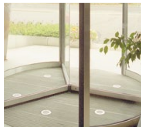
Faretti di illuminazione inseriti a pavimento nello zerbino
