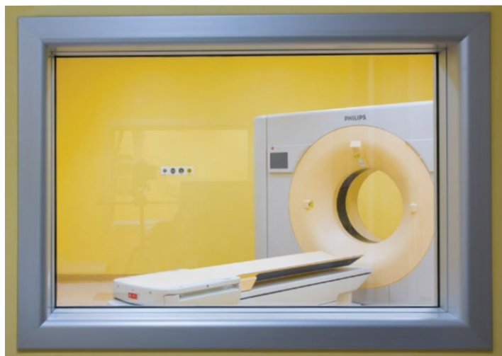
Visiva schermata anti raggi X che riduce al minimo i rischi causati dalle radiazioni
