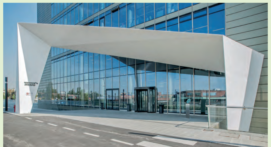
Particolare dell'area di ingresso in cui è collocata la porta girevole Ponzi
