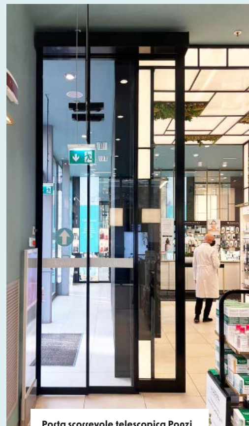
Porta scorrevole telescopica Ponzi TSA con ante di grandi dimensioni e sistema di apertura delle ante di sicurezza ridondante tramite pulsante di sicurezza
