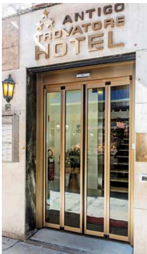
Hotel Antigo Trovatore – Venezia: porta pieghevole automatica Ponzi FTA, abilita a via di fuga i vani ristretti degli antichi centri storici
