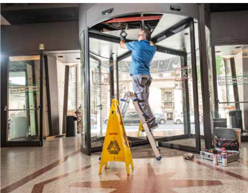
Intervento di manutenzione Ponzi su porta automatica girevole, secondo le differenti formule di contratto di assistenza
