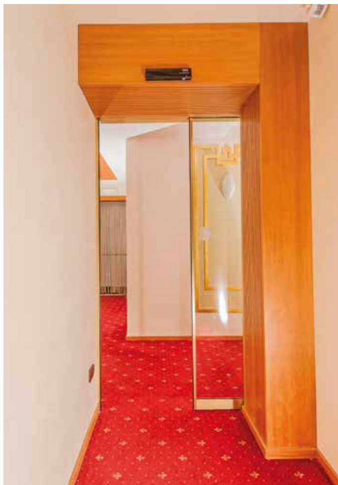
Compartimentazione interna: porta scorrevole automatica Ponzi monoanta per la separazione della zona camere
