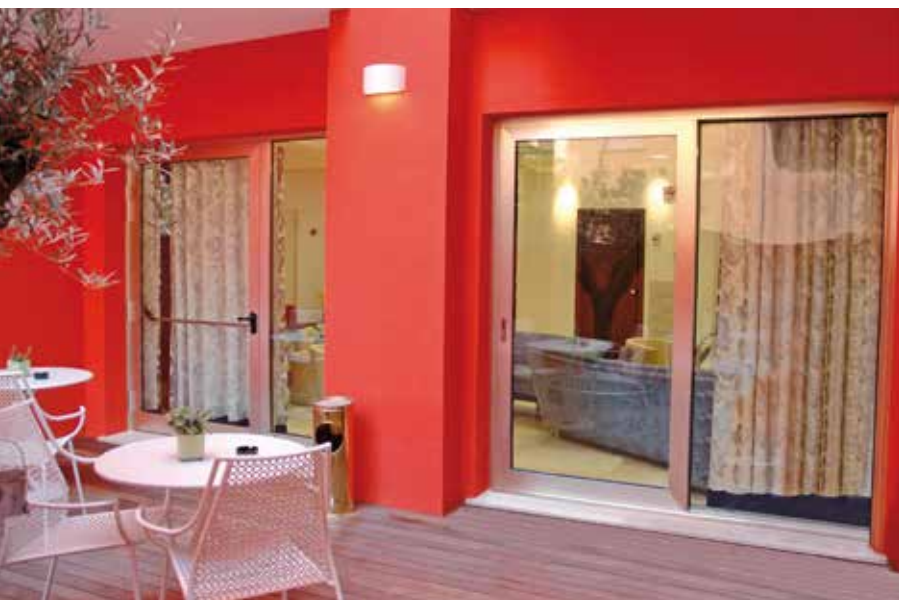
Divisione della sala da pranzo dalla zona giardino: vetrata e porta finestra scorrevole Ponzi con sistema "Alza e Scorri" con vista dall'interno e dall'esterno
