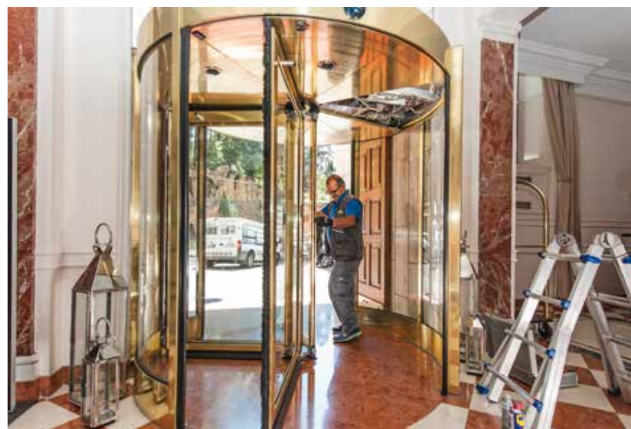
Intervento di riparazione su un’anta di una porta girevole. La riconosciuta professionalità nel settore serramentistico permette a Ponzi di riparare e sostituire direttamente anche i telai delle porte
