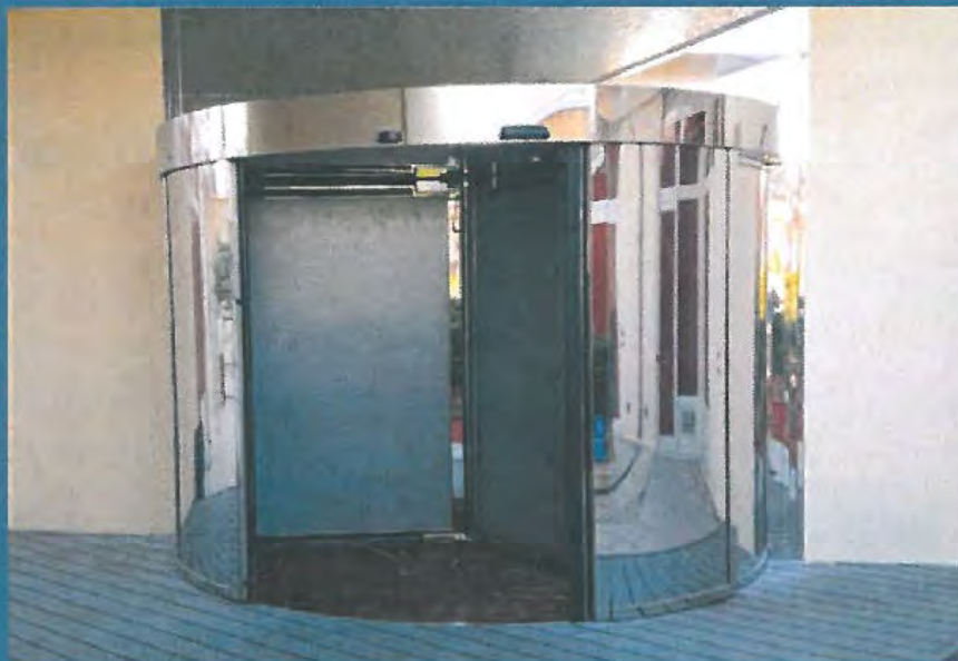
Porta girevole in acciaio inox con pellicole sabbiate installate sui vetri, per garantire la riservatezza dell'ambiente
