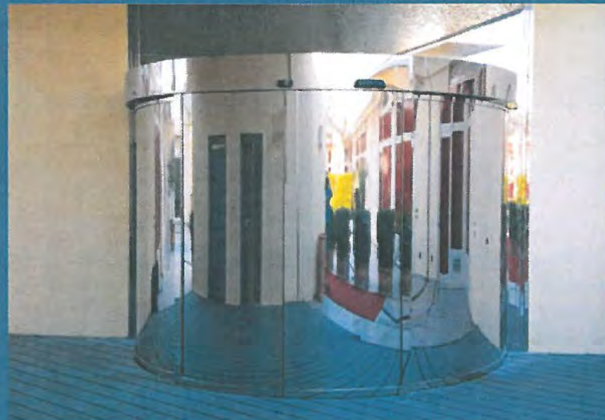
Porta girevole con ante scorrevoli notturne in posizione di chiusura. Le pellicole applicate sui vetri garantiscono la massima privacy
